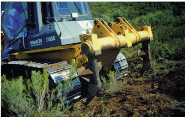
Bulldozer haciendo ahoyado mecánico.
