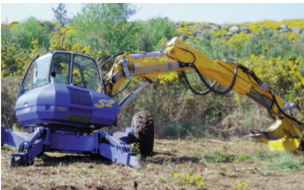
Retroaraña con cabezal de desbroce y ahoyado.
